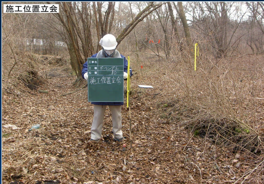
着手前の現場(調査位置の確認)
