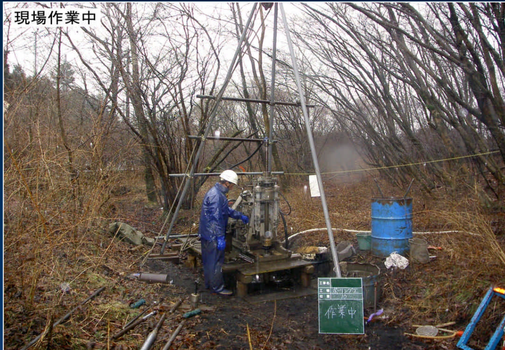
作業現場と仮設足場(平坦地)の状況
