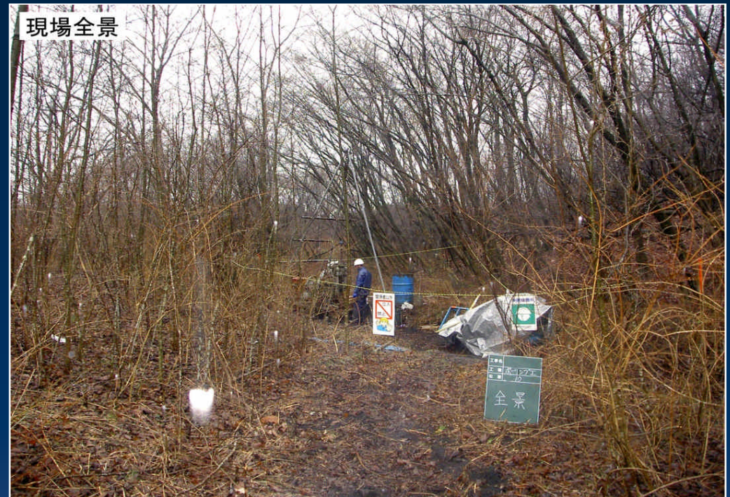
現場周辺の環境状況(仮囲いなど)
