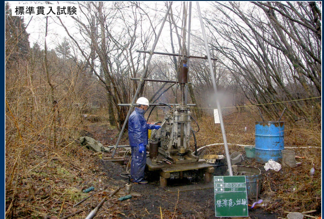
標準貫入試験(半自動落下)の実施状況
