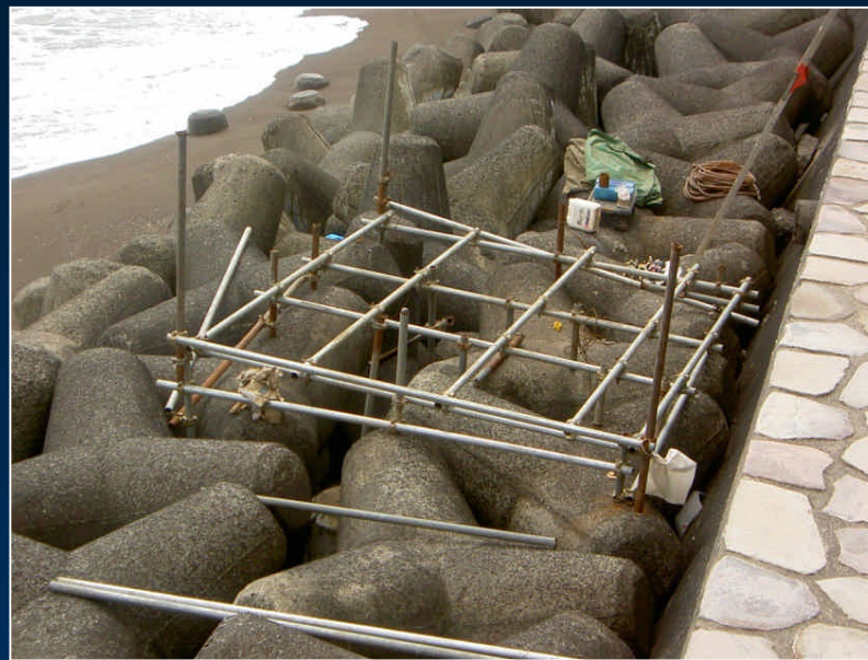
単管パイプ組
