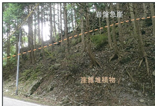
写真3 岩盤急崖脚部に堆積した崖錐堆積物
