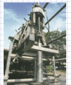
ボーリング調査
