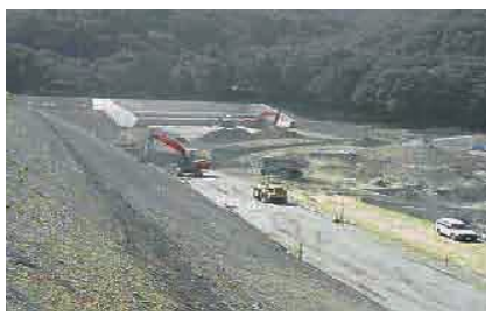
写真-1 堤体改修状況
