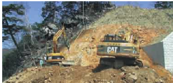
〈写真① 工事時の切土法面〉
