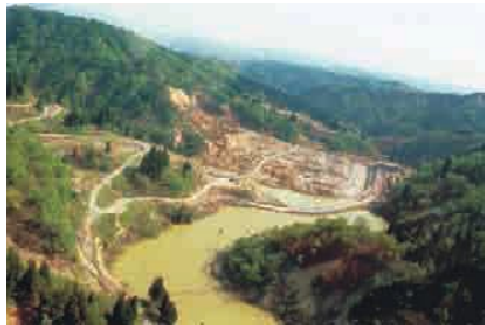
写真-1.東竹沢地区の地すべり河道閉塞
