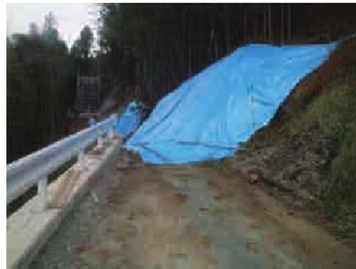
写真-2 道路終点側の崩壊による押し出し状況
