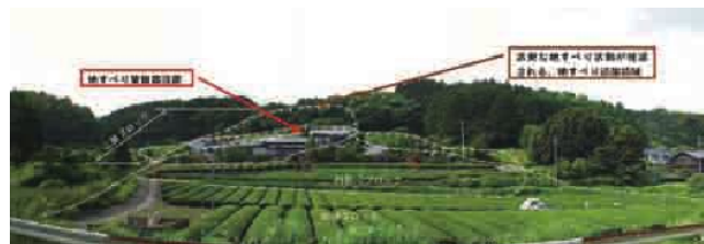
写真-2 吹木地区A-9ブロックの全景
