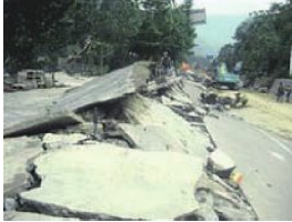
写真-1. 北川県の県庁所在地南東約1kmに現れた地震断層で道路に2.5mの落差が生じている (5月20日、林愛明教授撮影)
