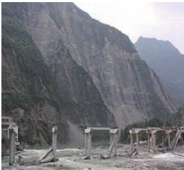
写真-2. 平武県市街地の北、省道205号橋河に架かるコンクリート橋の高橋 (7月30日、土屋智教授撮影)
