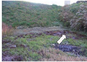
写真1-2 対策工完了(近景-乾燥状態)
