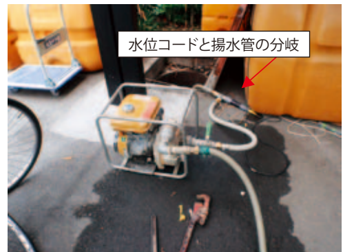
写真-1 陸上ポンプによる揚水
