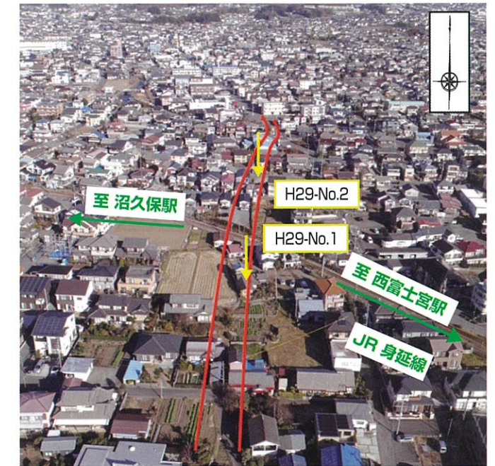
写真-1 調査地周辺の状況(UAV空撮)
