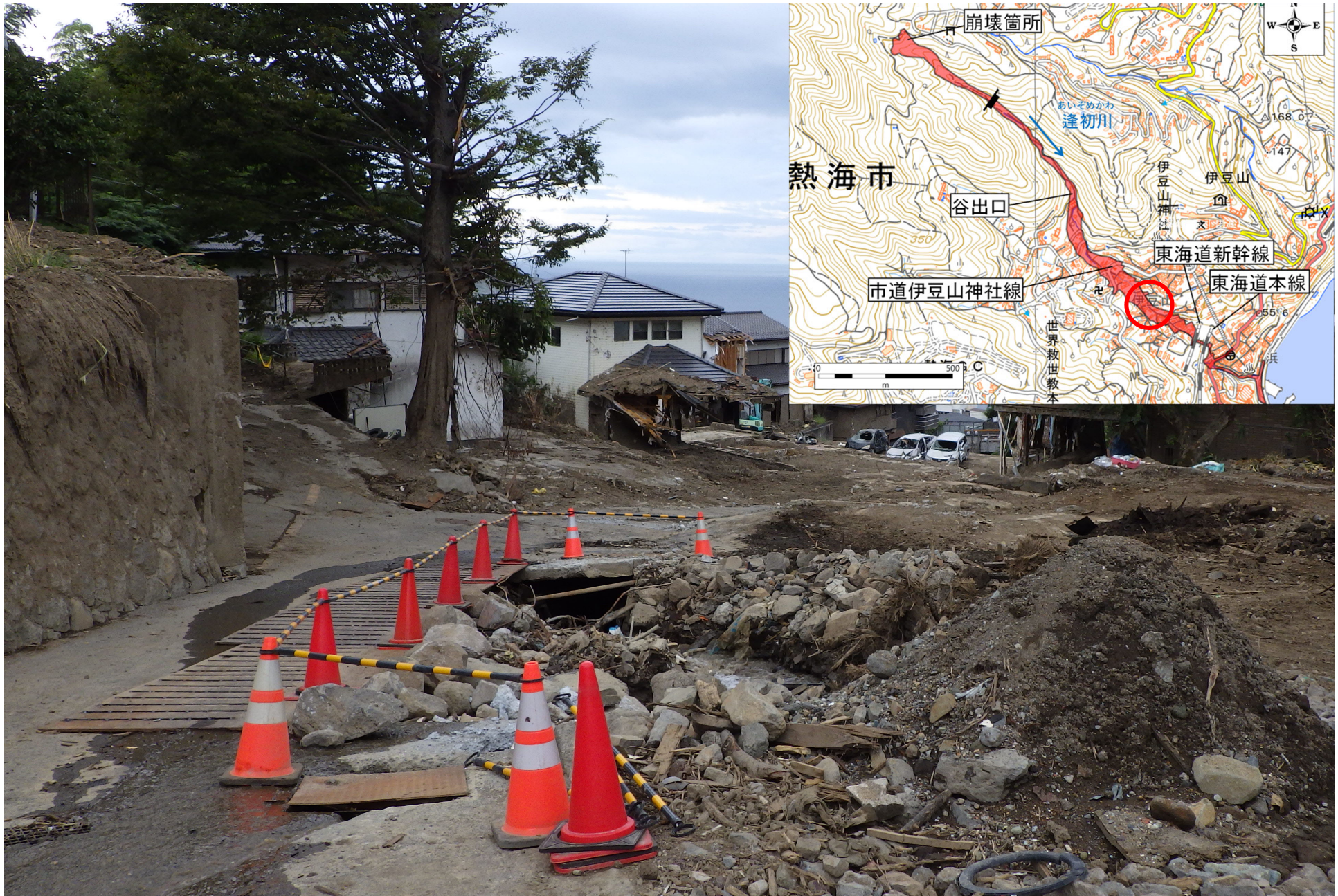
川が暗渠に⇒閉塞して氾濫
