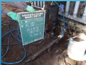
写真 崩野⑧流末配管（黒ポリエチレン管内）洗浄状況
