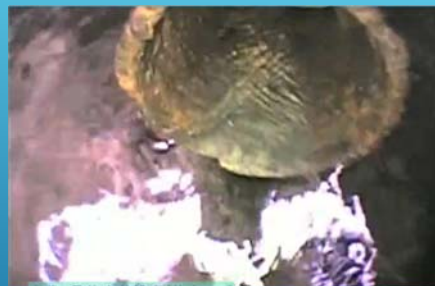
大代 No.3集水井排水ボーリング (井内より撮影；約4分)
