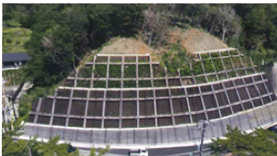
写真-3 完成写真
