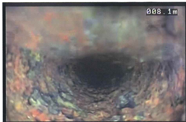
写真-1. ガス管の保孔管の様子 (水面下)
