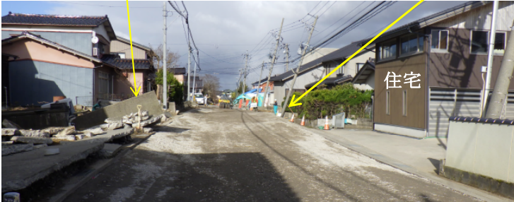
T型擁壁が道路に 突き出し 水平変位：90cm
