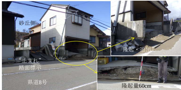
沿道の住宅の隆起例1：西荒屋地区、断面3
