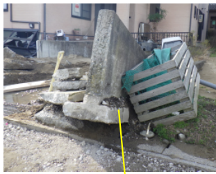
T型擁壁が道路に 突き出し 水平変位：90cm
