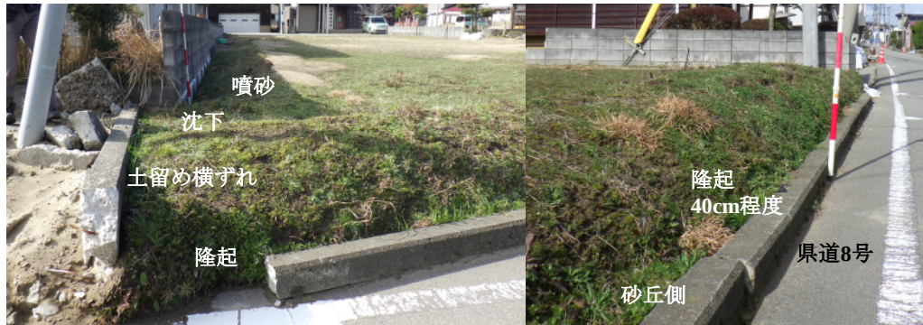
県道8号の砂丘側の裸地の隆起例：西荒屋地区、断面2付近
