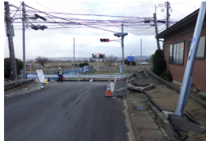
補修後の西荒屋交差点
