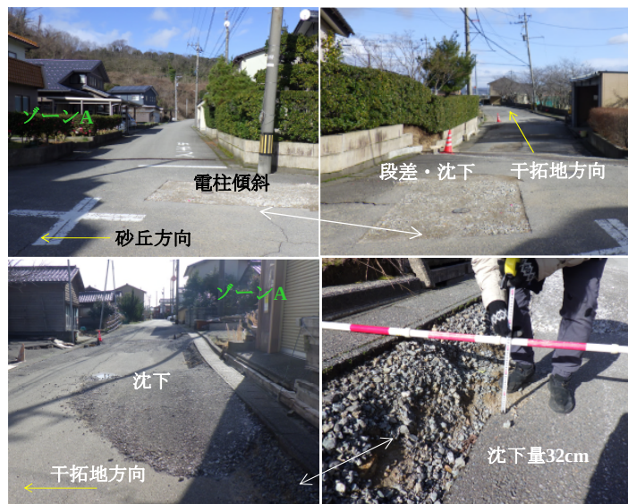
砂丘に隣接する街区とその前面道路
