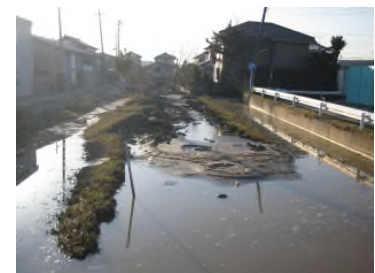
液状化により埋まった十間川 * 噴砂と地盤のずれがある 54
