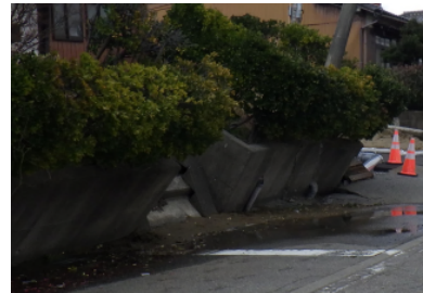
県道8号の砂丘側の噴砂と隆起による土留め壁（高さ90cm）の傾斜、傾斜角度：60°
