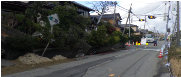
県道8号の砂丘側の噴砂と隆起による土留め壁（高さ90cm）の傾斜、傾斜角度：60°
