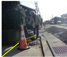
T型擁壁が道路に 突き出し 水平変位：90cm
