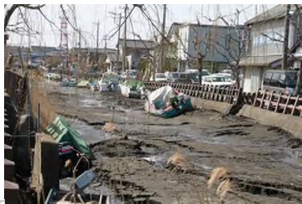
液状化の噴砂で埋まった小野川
