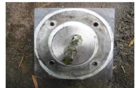
アンカーヘッド、くさび、鋼線余長には腐食による錆等の変状は見受けられない。
