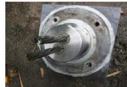
アンカーヘッド、くさび、鋼線余長には腐食による錆等の変状は見受けられない。
