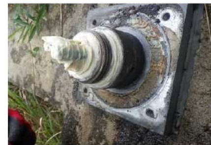
防錆油の量は十分であるが、変色して乳白色化している。
