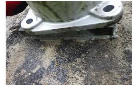
頭部キャップ開放時に水の流下を確認。
