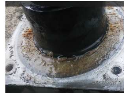
頭部キャップ開放時に水の流下を確認。
