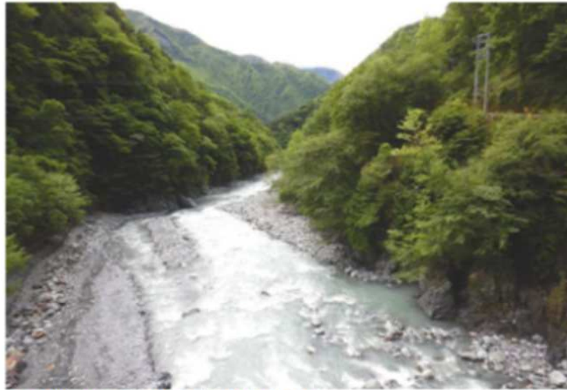
大井川（林道東俣線の滝見橋から撮影）
