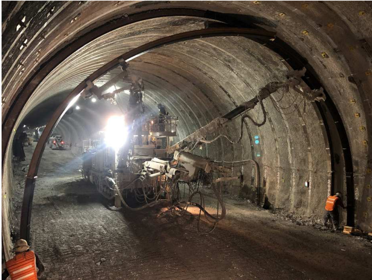
二次支保工施工状況(支保工建込み)
