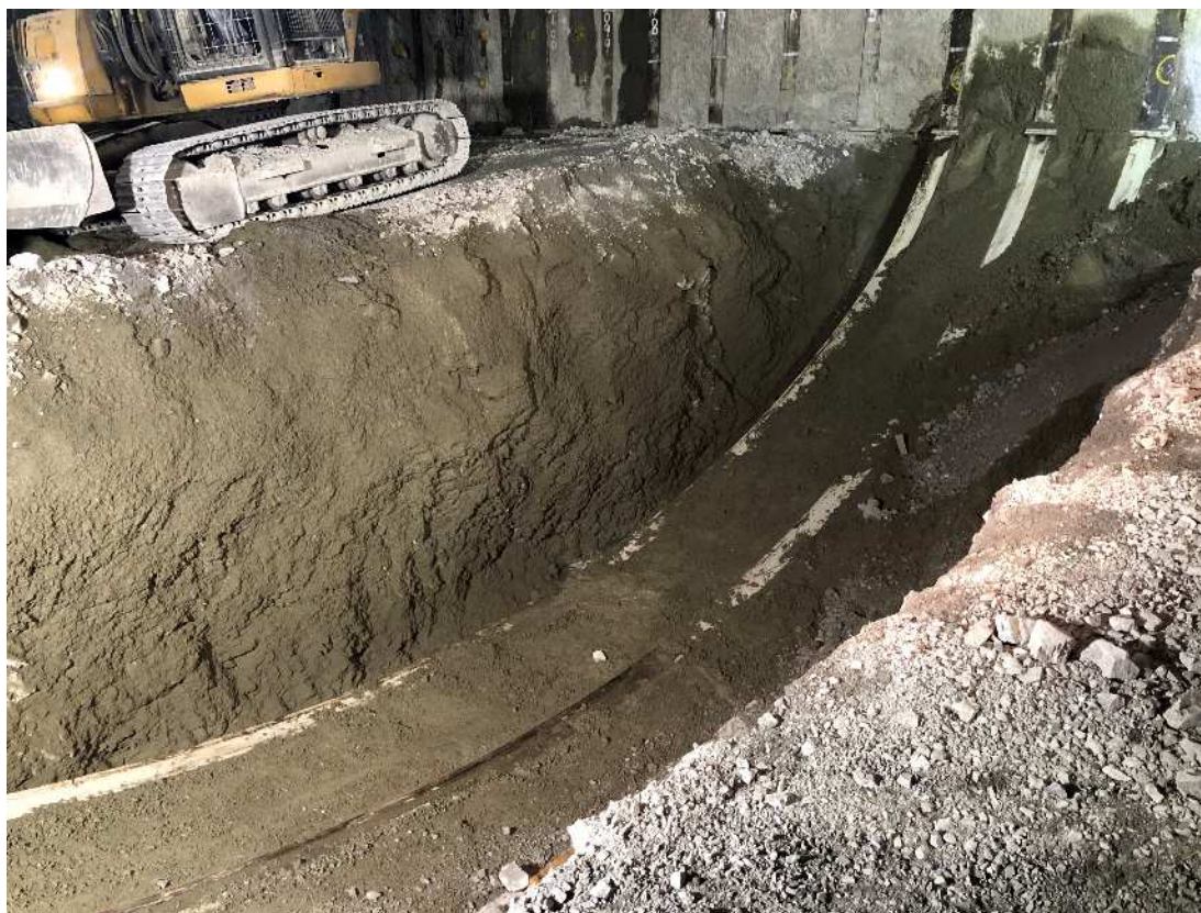
一次インバート施工状況
