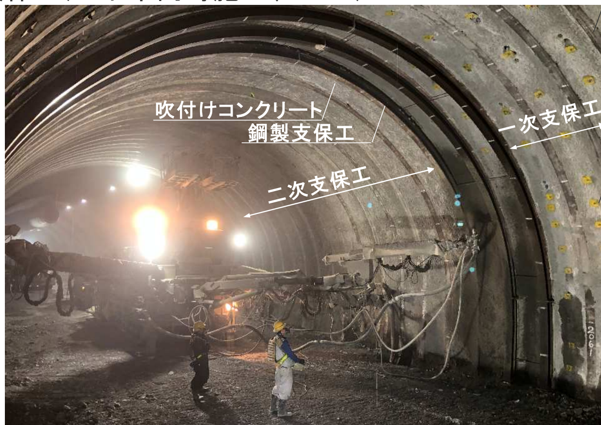
二次支保工施工状況(吹付けコンクリート)
