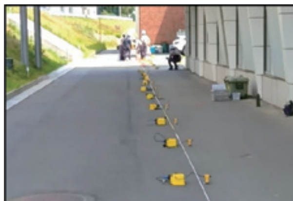
写真-2 微動アレイ探査状況(リニア(直線)配置)
