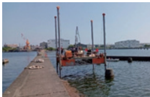
写真-1 海上ボーリング作業状況
