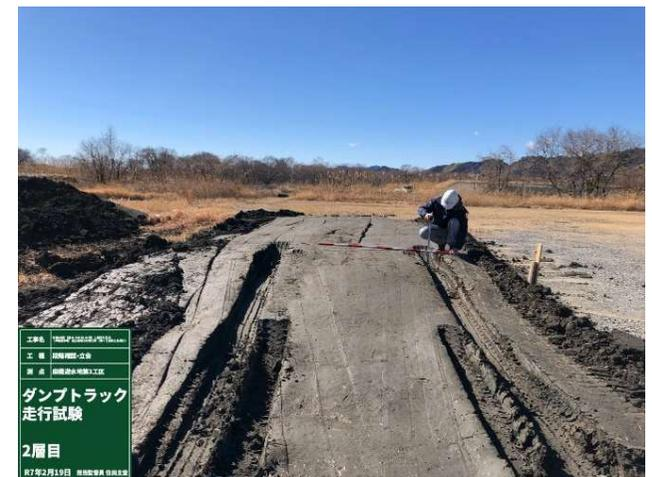
写真 土質改良工試験施工・ダンプトラック走行試験状況（第1工区掘削土）
